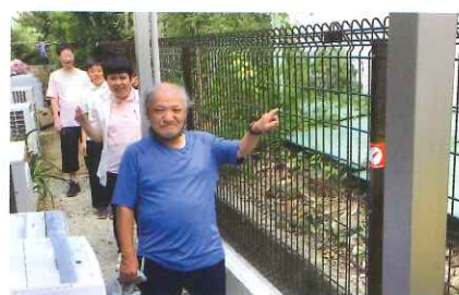
● 遠江学園まつかさ 防犯用ブロックフェンスの設置
